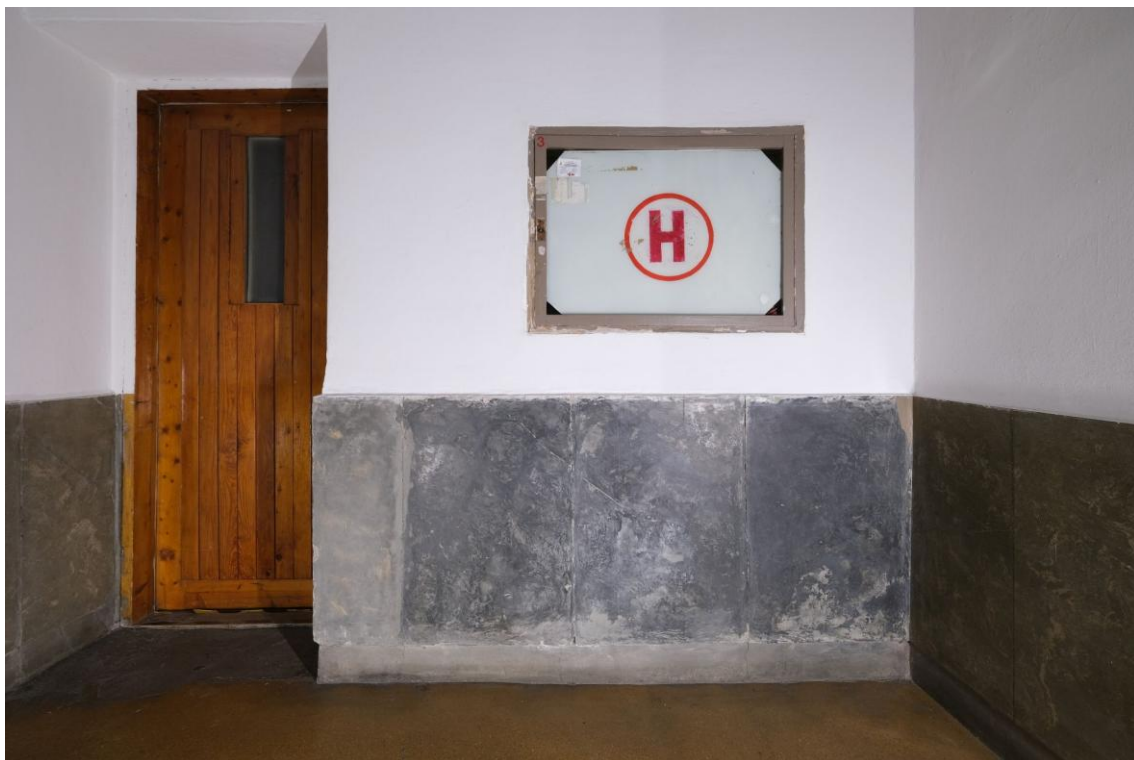
FOT. 120. TEATR POLSKI SCENA KAMERALNA, PÓŁNOCNA KLATKA SCHODOWA, PÓŁPIĘTRO NAD DRUGĄ KONDYGNACJĄ, ŚCIANA WSCHODNIA. ZNISZCZONA ORYGINALNA MARMORYACJA, UZUPEŁNIONA NIESTARANNIE. WTÓRNE DRZWI PROWADZĄCE DO NAROŻNEJ (PÓŁNOCNO-WSCHODNIEJ) KLATKI SCHODOWEJ.
