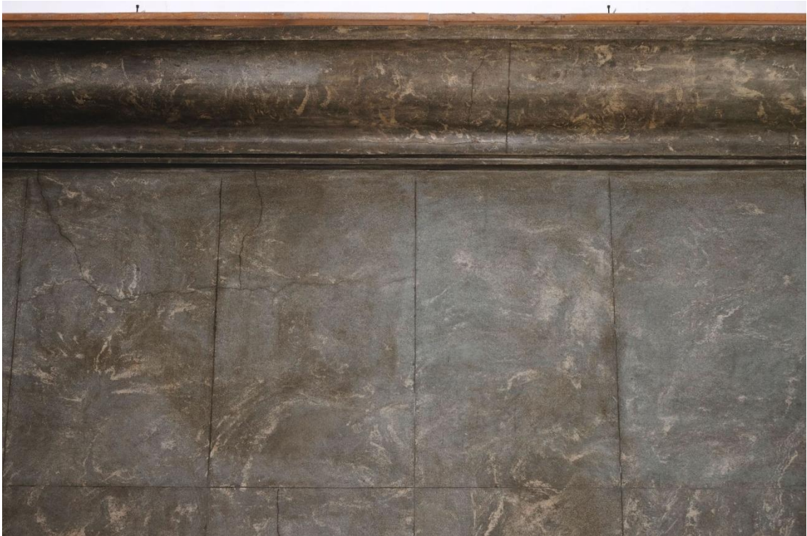
FOT. 77. TEATR POLSKI SCENA KAMERALNA, FOYER, OKŁADZINA ŚCIENNA Z MARMORYZACJĄ NA ŚCIANIE WSCHODNIEJ.
