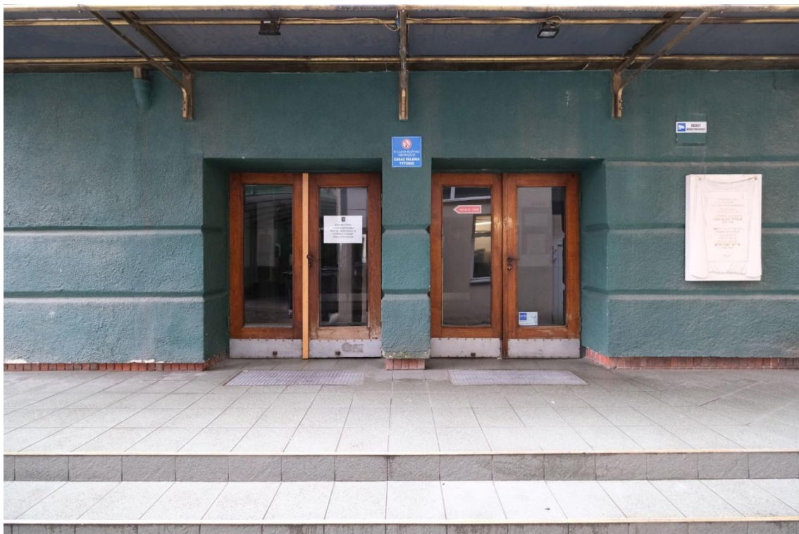
FOT. 21. TEATR POLSKI SCENA KAMERALNA, BUDYNEK GŁÓWNY TEATRU, ELEWACJA PÓŁNOCNA CZĘŚCI ZACHODNIEJ, WEJŚCIE GŁÓWNE. WIDOCZNE BONIOWANIE TYNKU ORAZ CERAMICZNY COKÓŁ ZASŁONIĘTY CZĘŚCIOWO PRZEZ PODEST.
