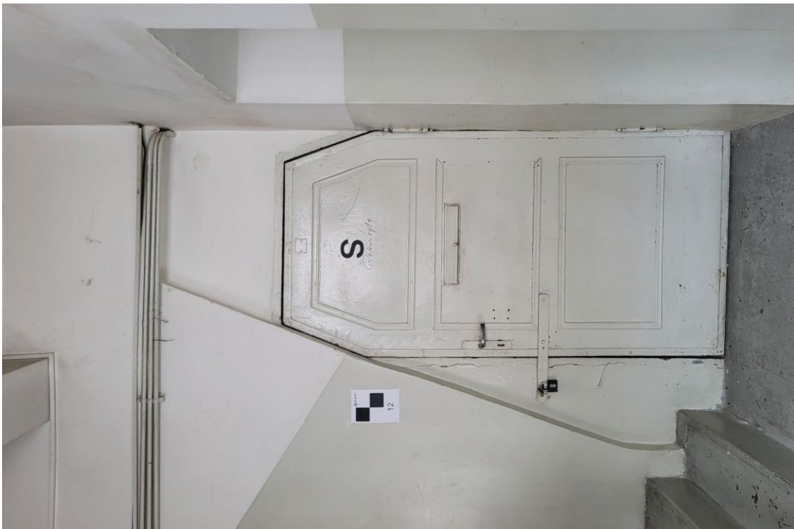
FOT. 30. TEATR POLSKI SCENA KAMERALNA, BUDYNEK GŁÓWNY TEATRU, WNĘTRZE NAROŻNEJ KLATKI SCHODOWEJ. ZACHOWANE STAŁOWE DRZWI Z 1912 R. W WEJŚCIU DO POMIESZCZENIA DRUGIEJ KONDYGNACJI (REKWIZYTORNI).
