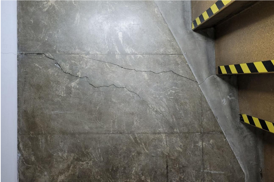
FOT. 75. TEATR POLSKI SCENA KAMERALNA, FOYER, OKŁADZINA ŚCIENNA Z MARMORYZACJĄ, GÓRNY BIEG SCHODÓW, ŚCIANA ZACHODNIA. WIDOCZNE SPĘKANIA JEDNEJ Z PŁYT.
