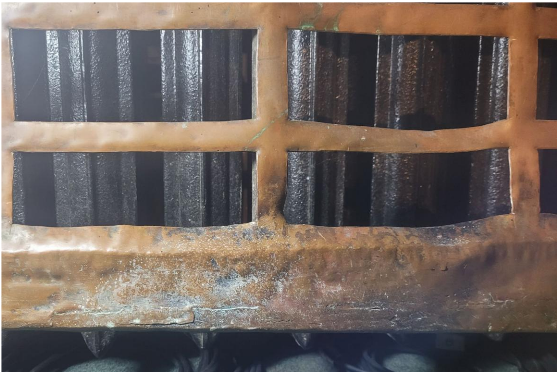
FOT. 98. TEATR POLSKI SCENA KAMERALNA, USZKODZONY FRAGMENT KRATY - OSŁONY GRZEJNIKA NA ŚCIANIE WSCHODNIEJ WIDOWNI.
