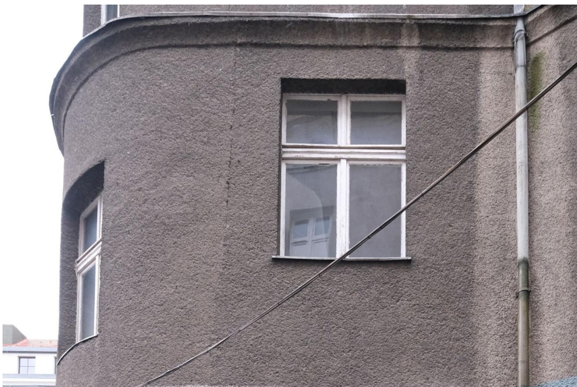
FOT. 18. TEATR POLSKI SCENA KAMERALNA, BUDYNEK GŁÓWNY TEATRU, ELEWACJA PÓŁNOCNA NAROŻNEJ KLATKI SCHODOWEJ. ZACHOWANE ELEMENTY ORYGINALNEJ STOLARKI OKIENNEJ Z 1912 R. WIDOCZNA FAKTURA TYNKU, ZAPEWNE Z CZASU POWOJENNEJ ODBUDOWY W 1949 R.
