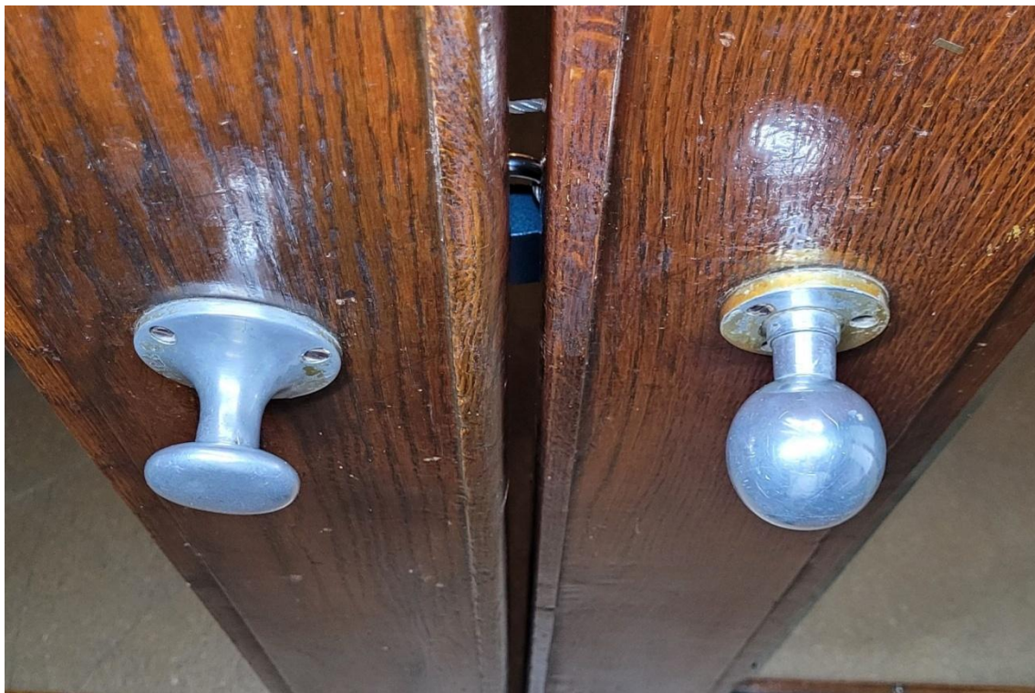
FOT. 125. TEATR POLSKI SCENA KAMERALNA, PÓŁNOCNA KLATKA SCHODOWA, PARTER, DRZWI WAHADŁOWE DO PRZEDSIONKA. ZACHOWANY ORYGINALNY UCHWYT (GAŁKA Z PRAWYJ) I WTÓRNY (Z LEWEJ).
