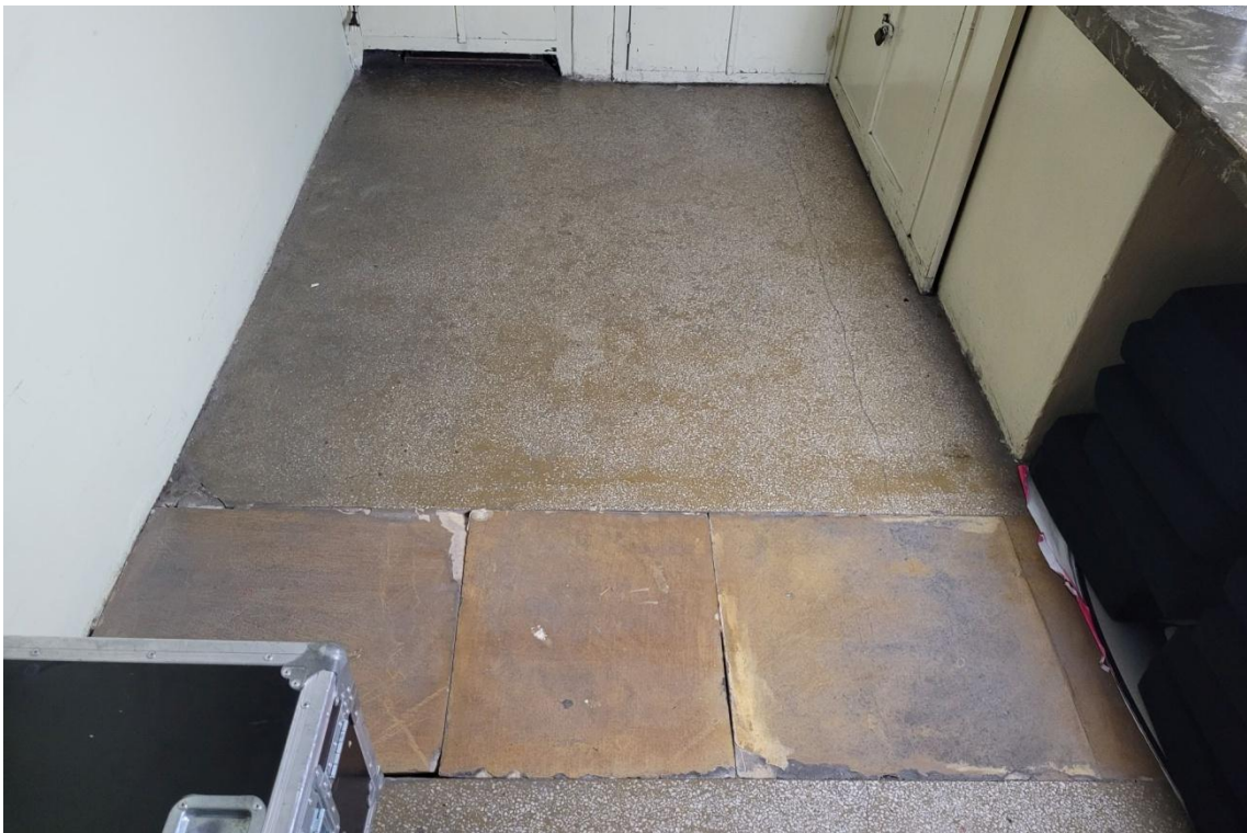
FOT. 62. TEATR POLSKI SCENA KAMERALNA, FOYER, POSADZKA WE WNĘTRZU SZATNI. WIDOCZNY KANAŁ TECHNICZNY ZAKRYTY PŁYTAMI.
