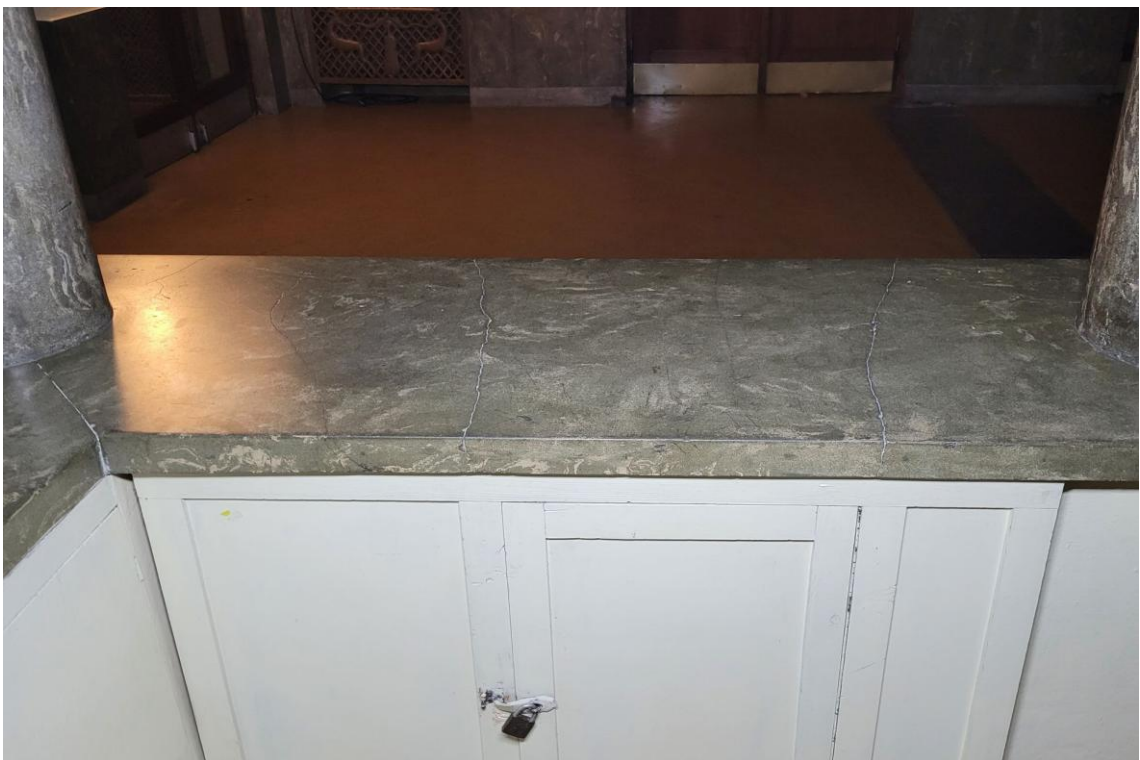
FOT. 58. TEATR POLSKI SCENA KAMERALNA, FOYER, SZATNIA, LADA - WIDOCZNE SPĘKANIA MARMORYZOWANEJ PŁYTY GÓRNEJ.
