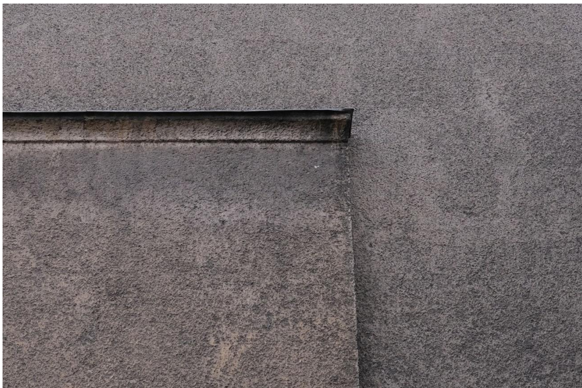
FOT. 24. TEATR POLSKI SCENA KAMERALNA, SKRZYDŁO POŁUDNIOWE, ELEWACJA PÓŁNOCNA. WIDOCZNA FAKTURA TYNKU Z CZASU POWOJENNEJ ODBUDOWY I ROZBUDOWY TEATRU W 1949 R., FRAGMENT FOT.23.
