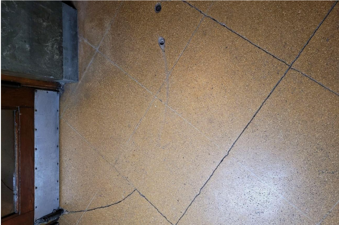
FOT. 63. TEATR POLSKI SCENA KAMERALNA, FOYER, POSADZKA TERRAZZO. WIDOCZNA IMITACJA PODZIAŁÓW NA PŁYTY ORAZ USZKODZENIA MECHANICZNE - SPĘKANIA ORAZ WYŻŁOBIENIA SPOWODOWANE NIEWŁAŚCIWYM UŻYTKOWANIEM.
