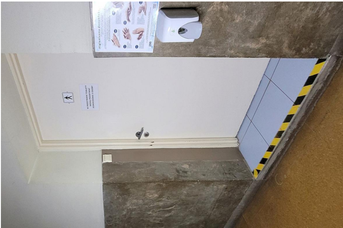
FOT. 76. TEATR POLSKI SCENA KAMERALNA, FOYER, GÓRNY PODEST SCHODÓW. WTÓRNIE, GŁĘBIEJ NIŻ PIERWOTNIE, OSADZONE DRZWI DO TOALETY.
