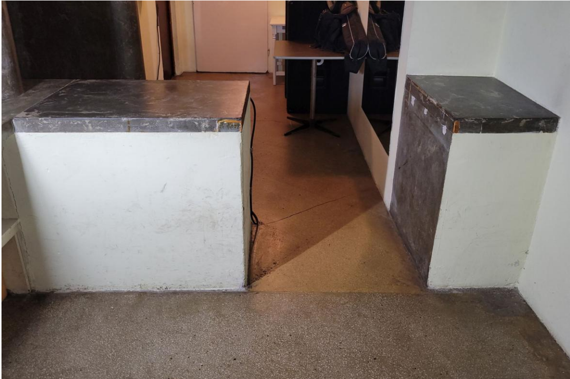
FOT. 61. TEATR POLSKI SCENA KAMERALNA, FOYER, WEJŚCIE DO SZATNI W CZĘŚCI POŁUDNIOWEJ, WIDOK OD STRONY WNĘTRZA. WIDOCZNE DWA RODZAJE POSADZKI TERRAZZO.
