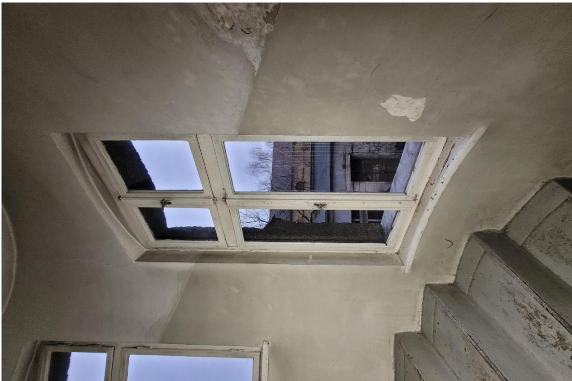
FOT. 28. TEATR POLSKI SCENA KAMERALNA, BUDYNEK GŁÓWNY TEATRU, WNĘTRZE NAROŻNEJ KLATKI SCHODOWEJ. ZACHOWANE ELEMENTY ORYGINALNEJ STOLARKI OKIENNEJ Z 1912 R. (LISTWY PRZYMYKOWE, PARAPET).
