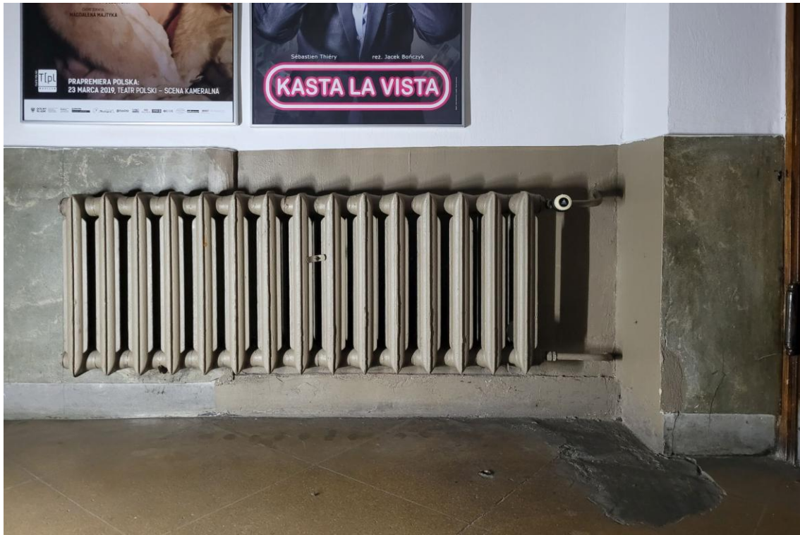
FOT. 119. TEATR POLSKI SCENA KAMERALNA, PÓŁNOCNA KLATKA SCHODOWA, KONDYGNACJA PARTERU, ŚCIANA POŁUDNIOWA. ZNISZCZONA ORYGINALNA MARMORYACJA, ZAPEWNE W ZWIĄZKU Z MONTAŻEM KALORYFERA.
