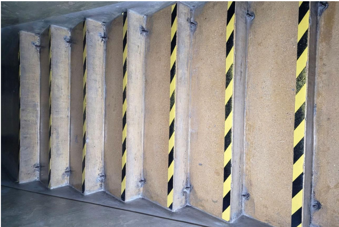
FOT. 121. TEATR POLSKI SCENA KAMERALNA, PÓŁNOCNA KLATKA SCHODOWA, BIEG SCHODOWY Z ZACHOWANYMI GWINTOWANYMI TRZPIENIAMI SŁUŻĄCYMI DO MONTAŻU CHODNIKA (DYWANU).
