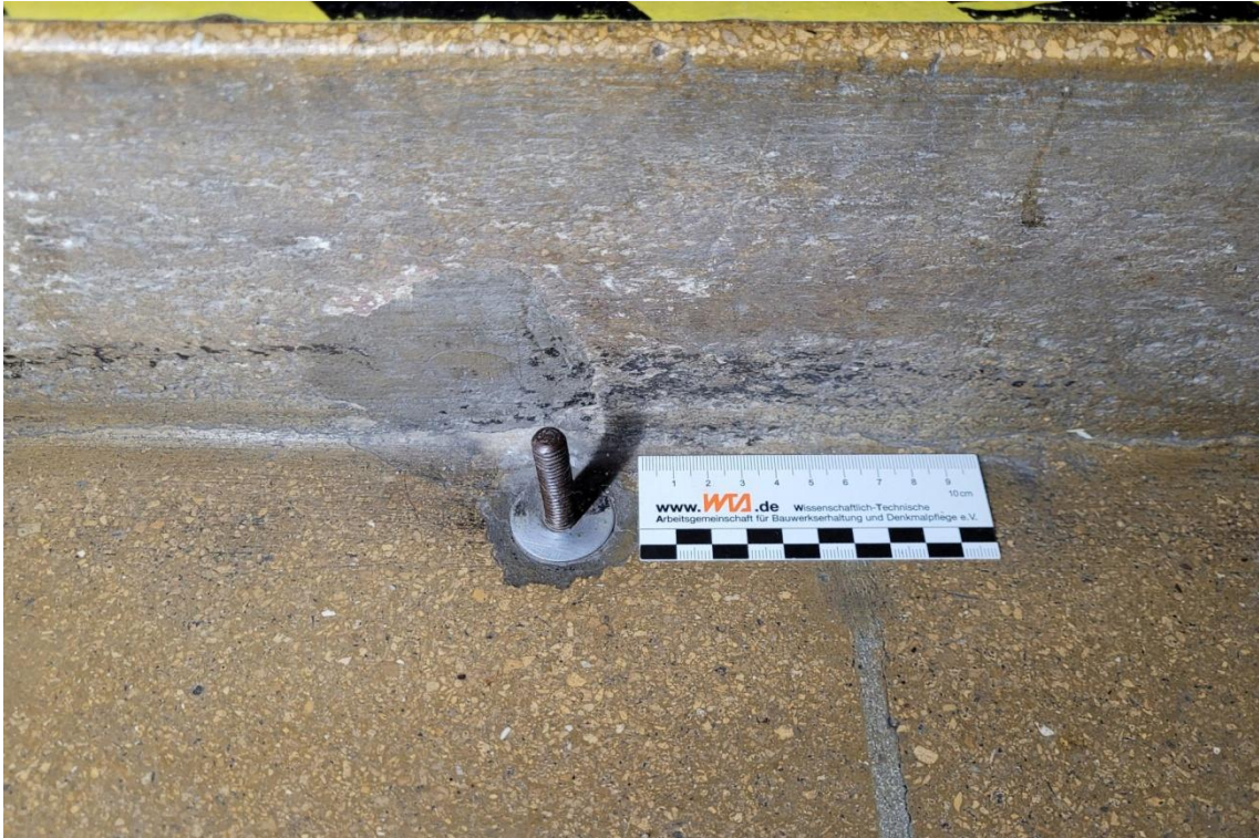
FOT. 71. TEATR POLSKI SCENA KAMERALNA, FOYER, SCHODY PROWADZĄCE NA ANTRESOLĘ - GWINTOWANY TRZPIEŃ OSADZONY W STOPNIU SCHODOWYM.
