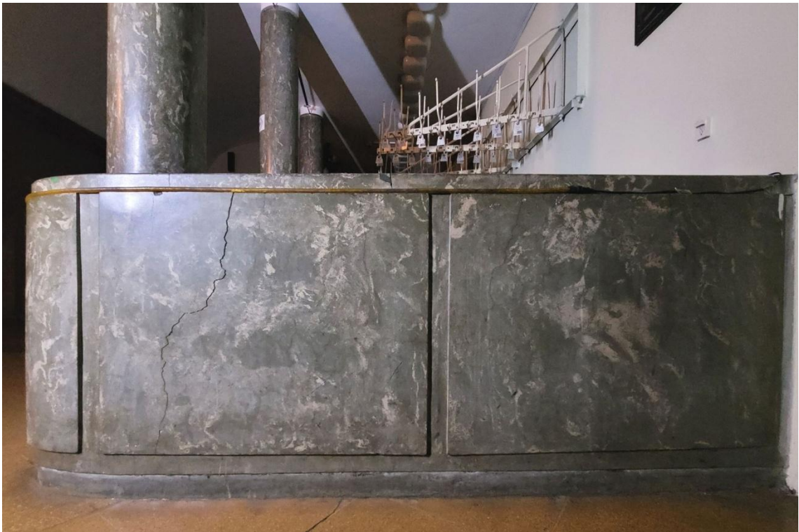
FOT. 57. TEATR POLSKI SCENA KAMERALNA, FOYER, SZATNIA, LADA - WIDOCZNE SPĘKANIA MARMORYZOWANEJ PŁYTY CZOŁOWEJ.
