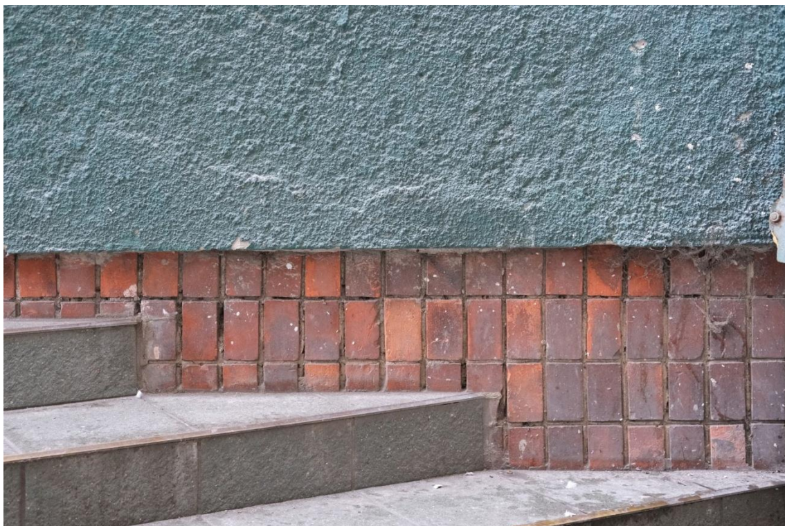
FOT. 22. TEATR POLSKI SCENA KAMERALNA, BUDYNEK GŁÓWNY TEATRU, ELEWACJA PÓŁNOCNA CZĘŚCI ZACHODNIEJ. WIDOCZNY CERAMICZNY COKÓŁ ZASŁONIĘTY CZĘŚCIOWO PRZEZ SCHODY PRZED WEJŚCIEM GŁÓWNYM.
