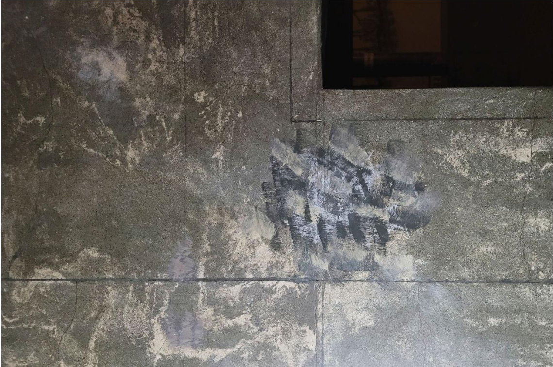
FOT. 41. TEATR POLSKI SCENA KAMERALNA, WNĘTRZE WIDOWNI. MARMORYZACJA NA ŚCIANIE ZACHODNIEJ, WIDOCZNE NIESTARANNE NAPRAWY.
