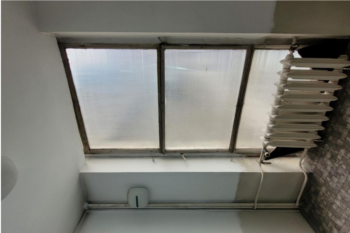
FOT. 141. TEATR POLSKI SCENA KAMERALNA, SKRZYDŁO POŁUDNIOWE. OKNO NA KLATCE SCHODOWEJ, PODEST MIĘDZY KONDYGNACJAMI 1 I 2 PIĘTRA. ZACHOWANE SZKLENIE SZKŁEM ORNAMENTOWYM RYFLOWANYM.
