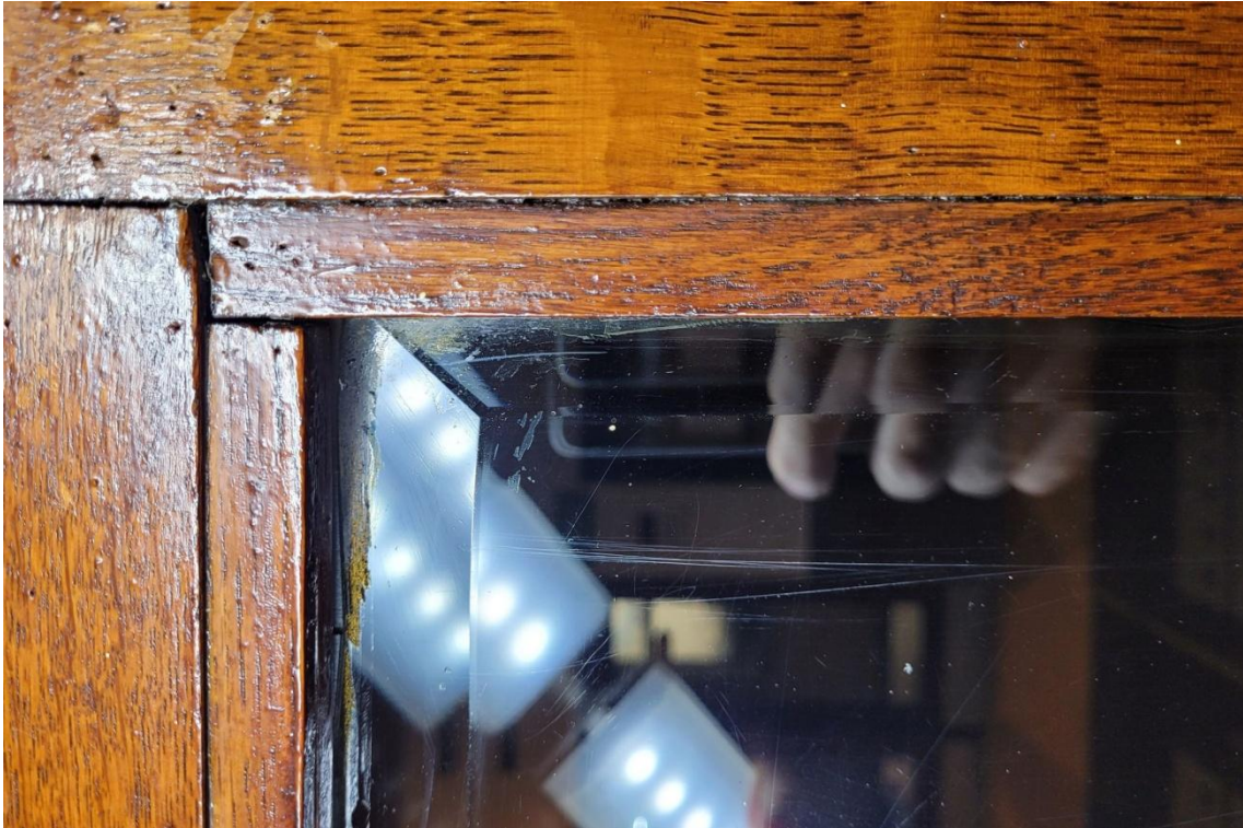
FOT. 85. TEATR POLSKI SCENA KAMERALNA, FOYER, DRZWI WAHADŁOWE WEJŚCIA GŁÓWNEGO, ZACHOWANE ORYGINALNE SZKLENIE Z FAZĄ.
