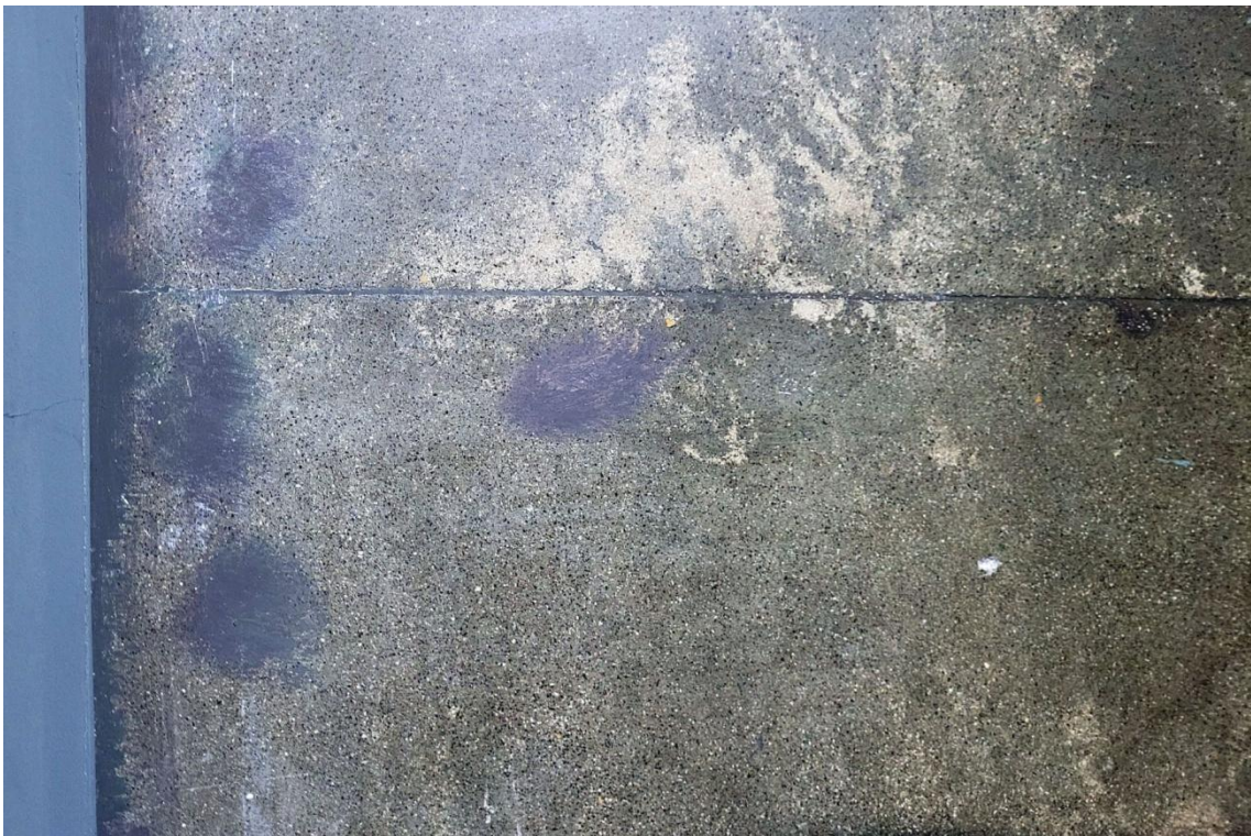
FOT. 40. TEATR POLSKI SCENA KAMERALNA, WNĘTRZE WIDOWNI. FRAGMENT MARMORYZACJI NA ŚCIANIE ZACHODNIEJ, WIDOCZNE NIESTARANNE NAPRAWY.
