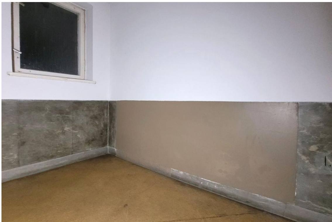
FOT. 132. TEATR POLSKI SCENA KAMERALNA, SZATNIA (LOBBY) NAD FOYER, ZNISZCZONY FRAGMENT ORYGINALNEJ MARMORYZOWANEJ OKŁADZINY ŚCIENNEJ.
