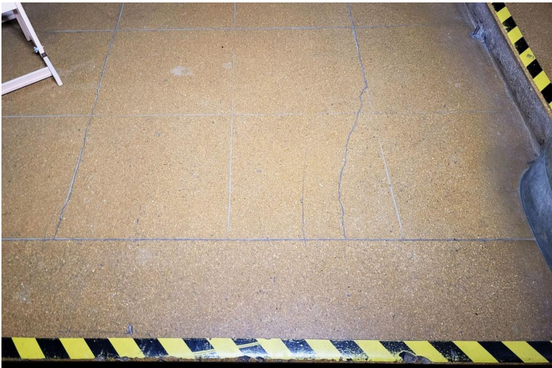
FOT. 72. TEATR POLSKI SCENA KAMERALNA, FOYER, DOLNY PODEST SCHODÓW, POSADZKA TERRAZZO. WIDOCZNY UKŁAD PROSTOPADŁY PODZIAŁÓW SPOINOWYCH.
