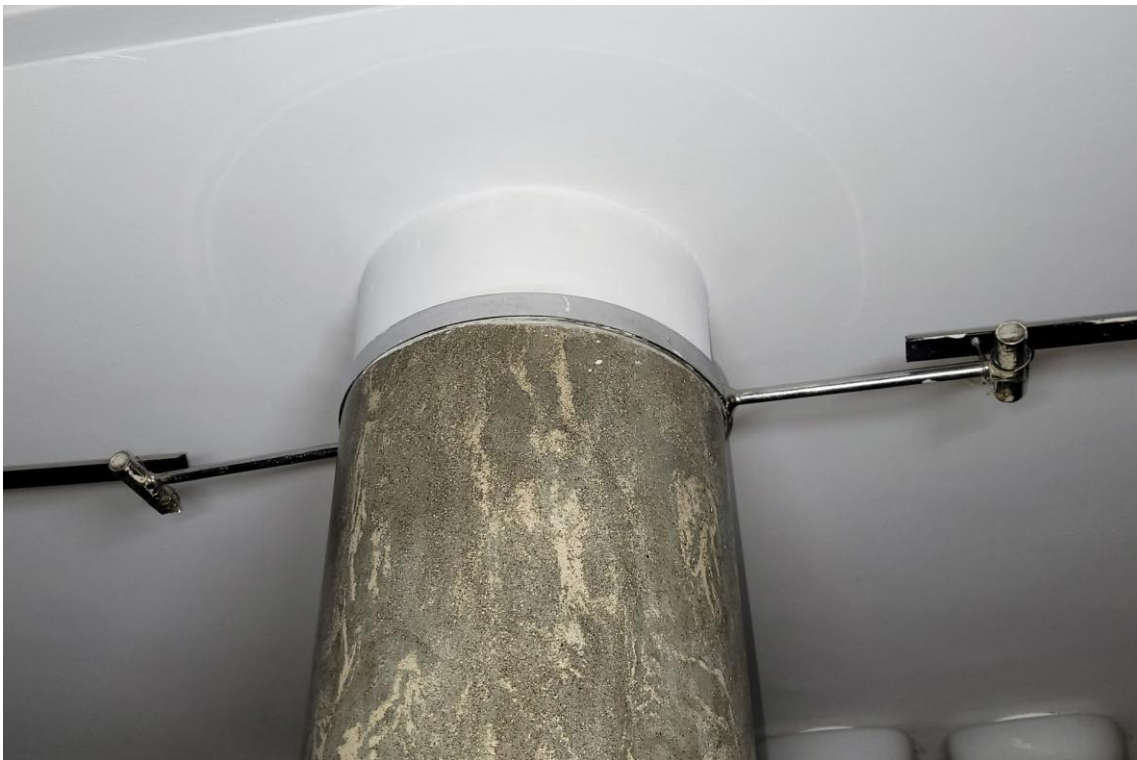
FOT. 56. TEATR POLSKI SCENA KAMERALNA, FOYER, SZATNIA, KOLUMNA. WIDOCZNA CHROMOWANA OBEJMA WOKÓŁ GÓRNEJ CZĘŚCI TRZONU ORAZ SŁABO CZYTELNA TALERZOWA GŁOWICA.
