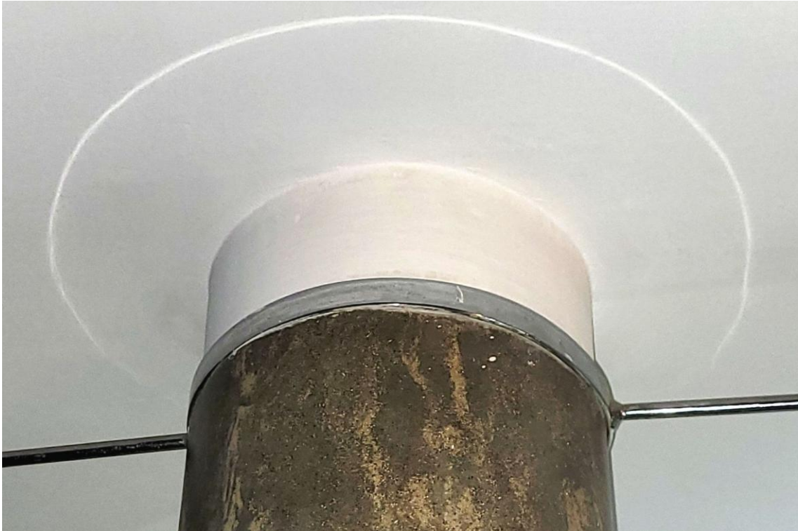
FOT. 55. TEATR POLSKI SCENA KAMERALNA, FOYER, SZATNIA, KOLUMNA. WIDOCZNA CHROMOWANA OBEJMA WOKÓŁ GÓRNEJ CZĘŚCI TRZONU ORAZ TALERZOWA GŁOWICA.
