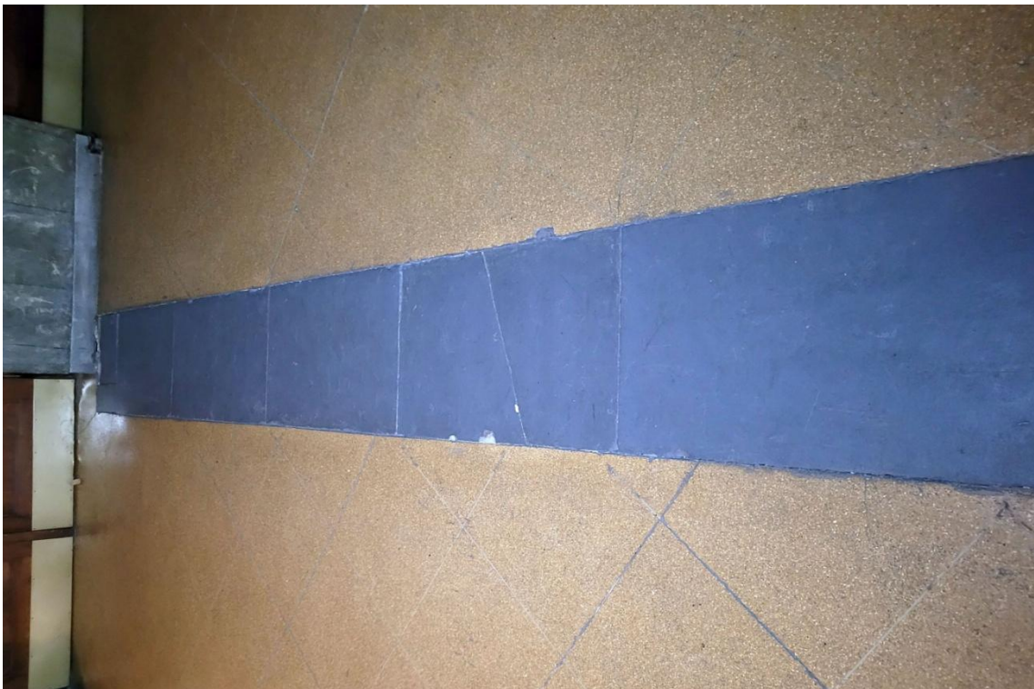
FOT. 64. TEATR POLSKI SCENA KAMERALNA, FOYER, POSADZKA TERRAZZO. WIDOCZNY KANAŁ TECHNICZNY ZAKRYTY PŁYTAMI O KONTRASTUJĄCYM KOLORZE.
