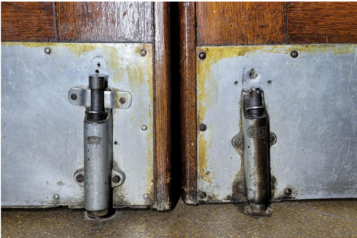
FOT. 84. TEATR POLSKI SCENA KAMERALNA, FOYER, DRZWI WAHADŁOWE WEJŚCIA GŁÓWNEGO, ZACHOWANE ORYGINALNE ELEMENTY OKUĆ.
