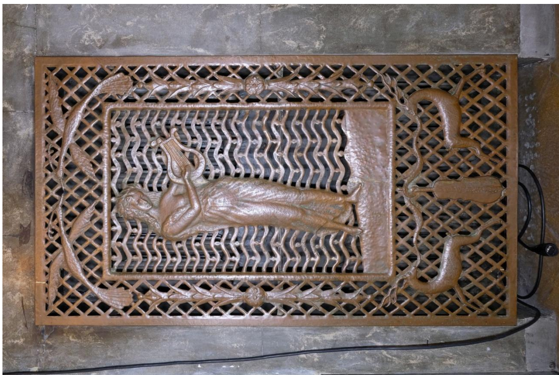
FOT. 99. TEATR POLSKI SCENA KAMERALNA, OZDOBNA KRATA - OSŁONA GRZEJNIKA NA ŚCIANIE WSCHODNIEJ FOYER PRZY WEJŚCIU GŁÓWNYM.
